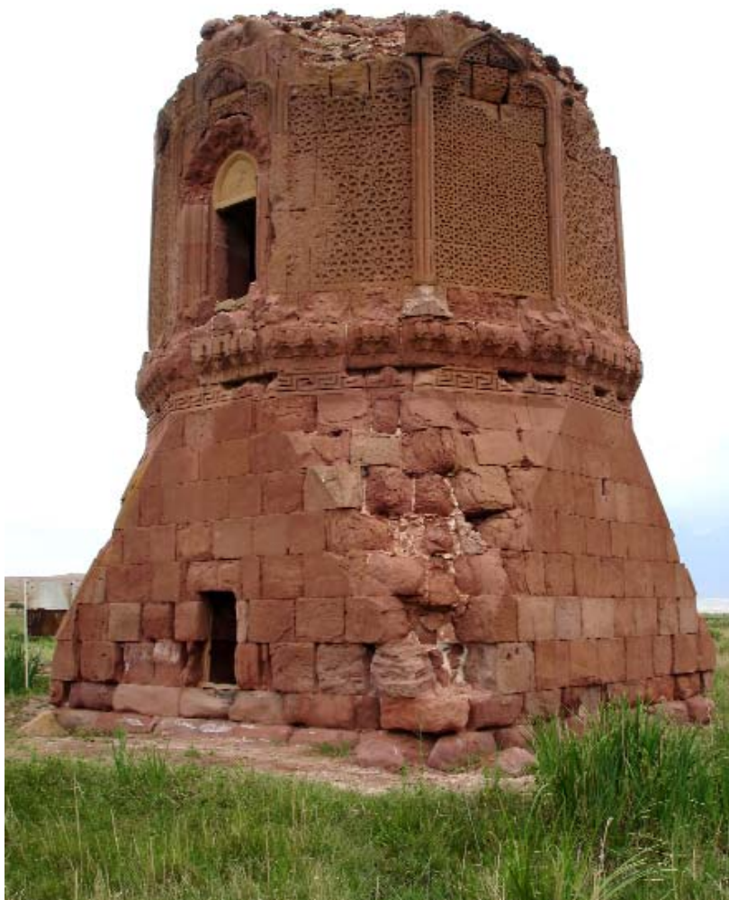
Şəkil 105. Gülüstan türbəsi (təmirdən əvvəl)
