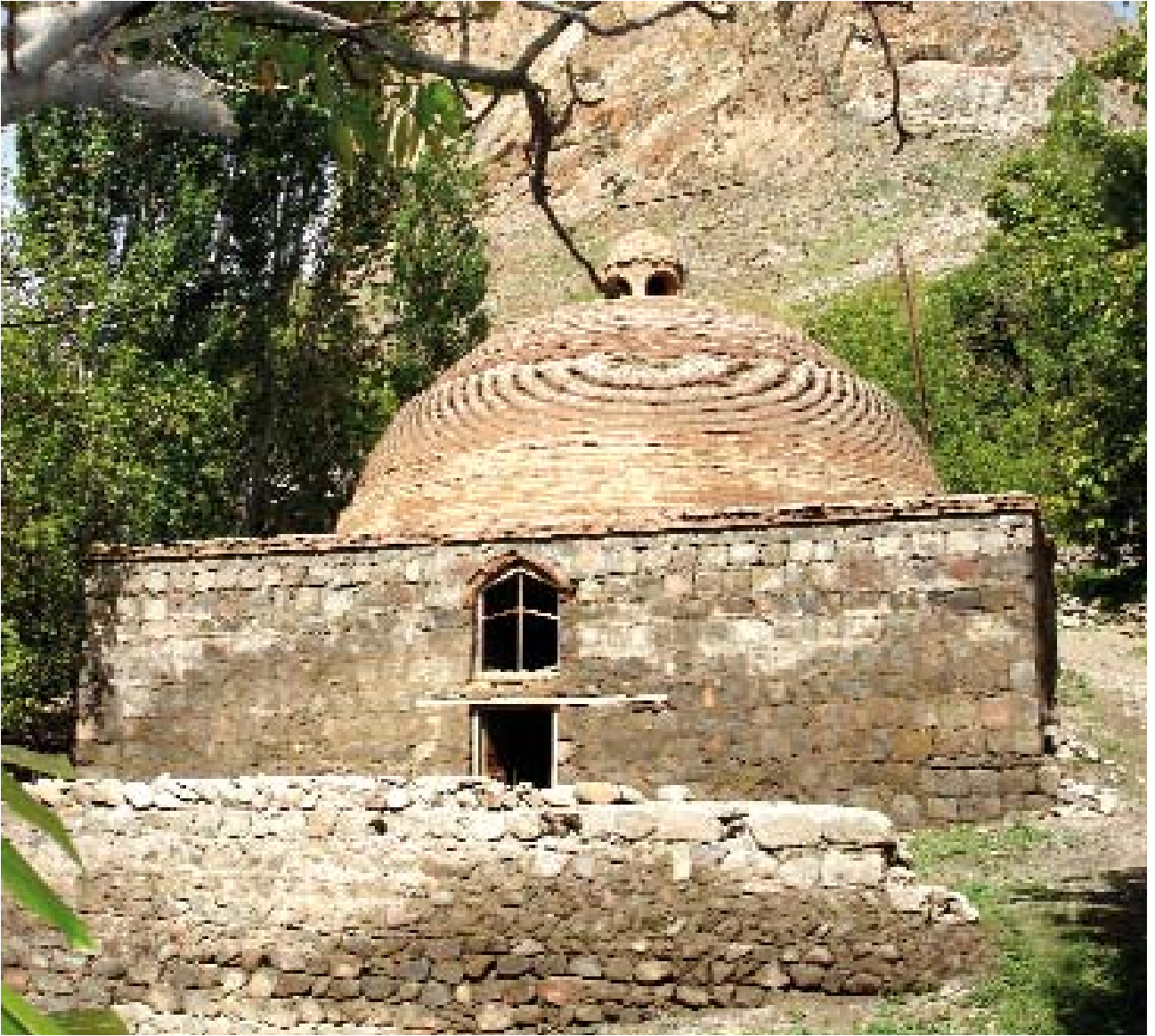
Şəkil 119. Əmirxan türbəsi.
