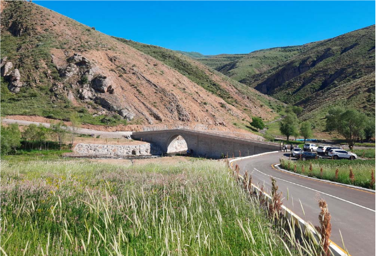
Şəkil 131. Ləkətağ körpüsü (bərpadan sonra)
