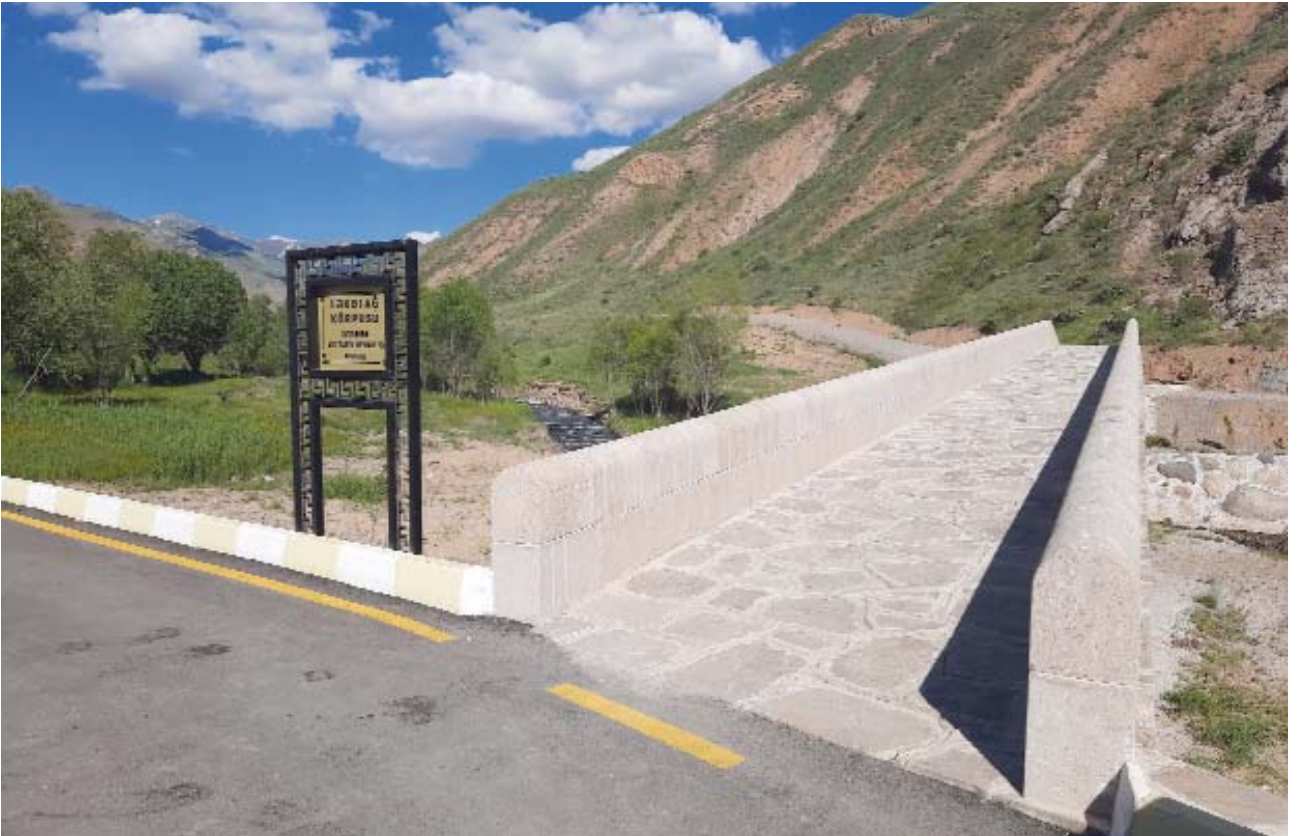
Şəkil 132. Ləkətağ körpüsü (bərpadan sonra)
