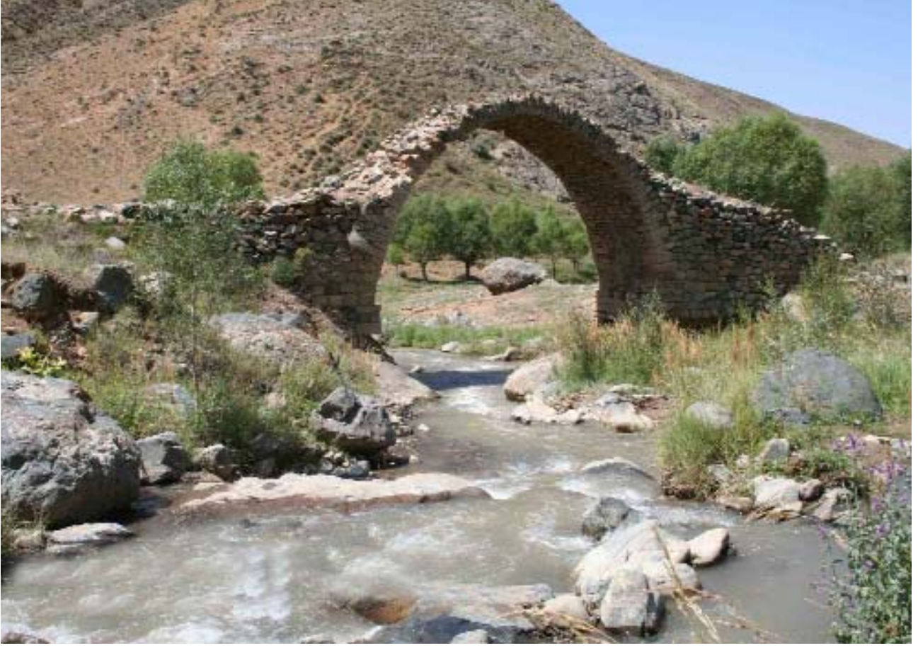
Şəkil 130. Ləkətağ körpüsü (bərpadan əvvəl)
