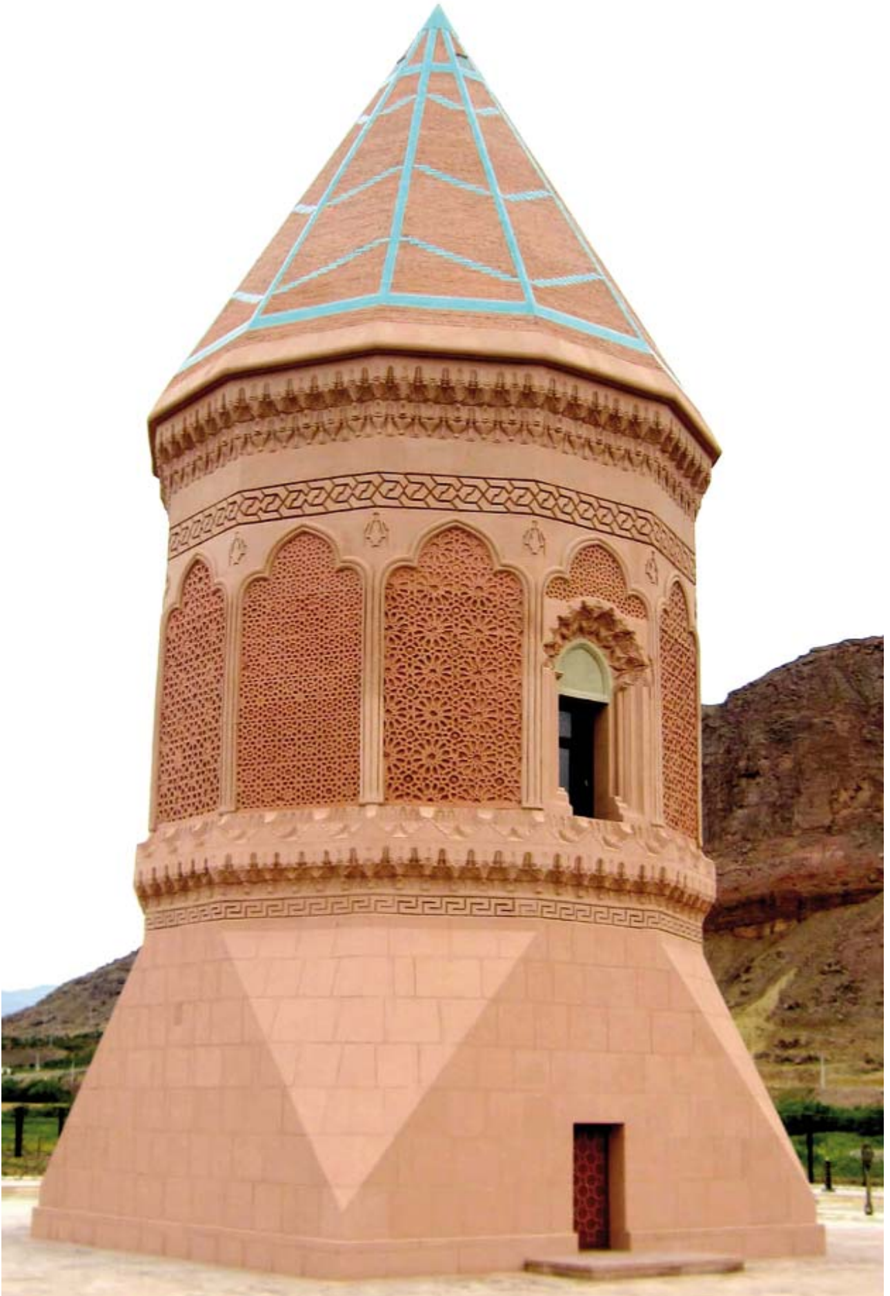
Şəkil 106. Gülüstan türbəsi təmirdən sonra
